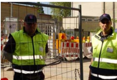
Nico Sieberts und Wachleiter Ben Sprünker bewachen die Zufahrt zur Einsturzstelle
