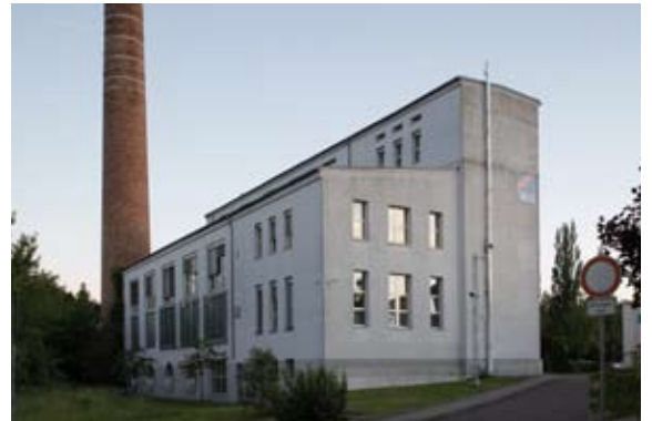
Der Sicherheitsbereich in einem ehemaligen Kraftwerk bietet unserer AlarmEmpfangsStelle optimalen Schutz.
